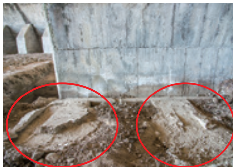
4号掩体後部アーチの コンクリート基礎台
