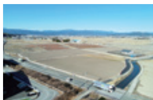
浜改田西部工区整備後
